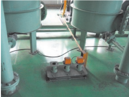
循環水ピットのオーバーフロー防止のために取り付けられた水位センサー（エコテクノロジーカンパニー）
