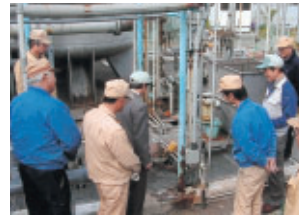
現場で各槽のPH計と液面センサーの確認をしている
