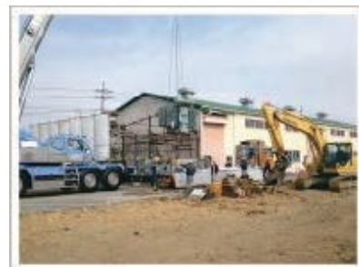
PCB廃棄物搬出作業状況
