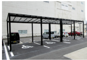
車いす利用者向けの駐車場 （群馬製作所・西本館）
