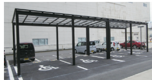
車いす利用者向けの駐車場 (群馬製作所・西本館)
