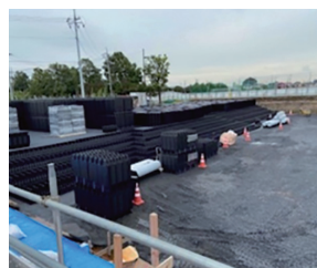
雨水貯留槽設置工事
