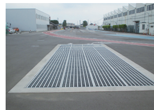
浸水対策（排水口）（宇都宮製作所）
