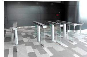
車いすの方も通門できる入出門ゲート (群馬製作所・西本館)
