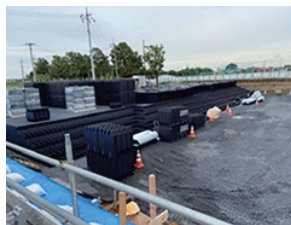
雨水貯留槽設置工事
