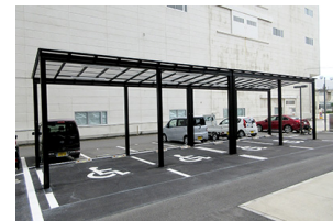
車いす利用者向けの駐車場 (群馬製作所・西本館)
