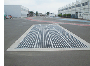
浸水対策（排水口）（宇都宮製作所）
